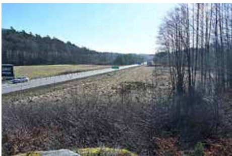
Fastigheten byggs vid väg 158.
