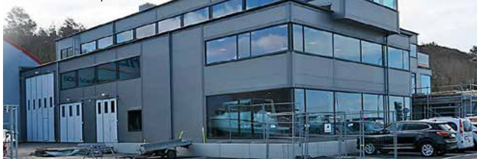
Wahlborgs Marina i Västra Frölunda i Göteborg har byggt nytt. Foto: Lars Afzelius.
